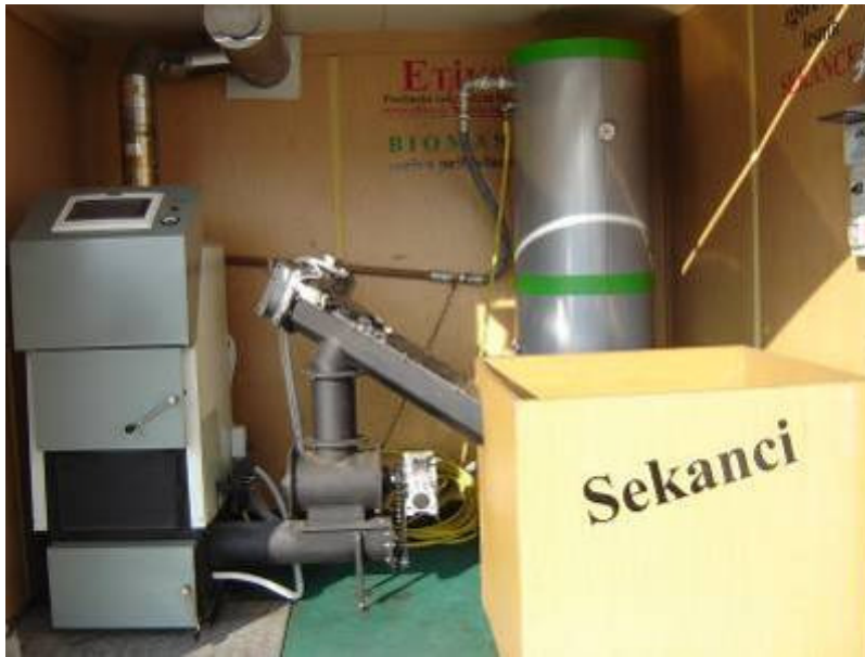
Slika 5: Sistem za ogrevanje na biomaso (Foto: Veronika Cvetko)
