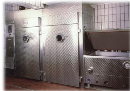
Slika 42: Kotel za kuhanje in komore (za toplotno obdelavo in prekajevanje)
