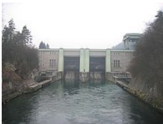
Hidroelektrarna Medvode Vir: http://sl.wikipedia.org/wiki/Hidroelektrarna
