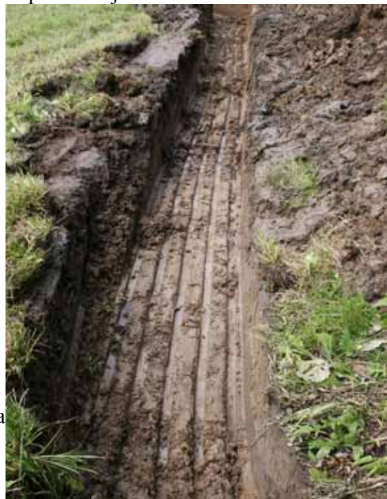
Fotografija 31: Izkop drenažnega jarka (Vir: Anton Goršič)
