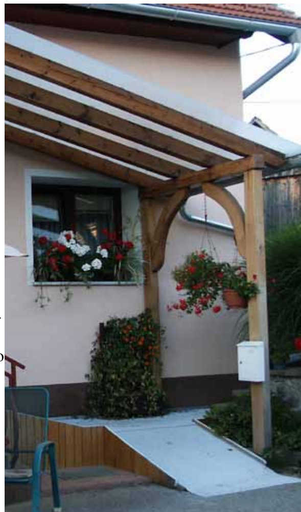
Fotografija 49: Po gradbenih in tesarskih delih (Vir: Anton Goršin)
