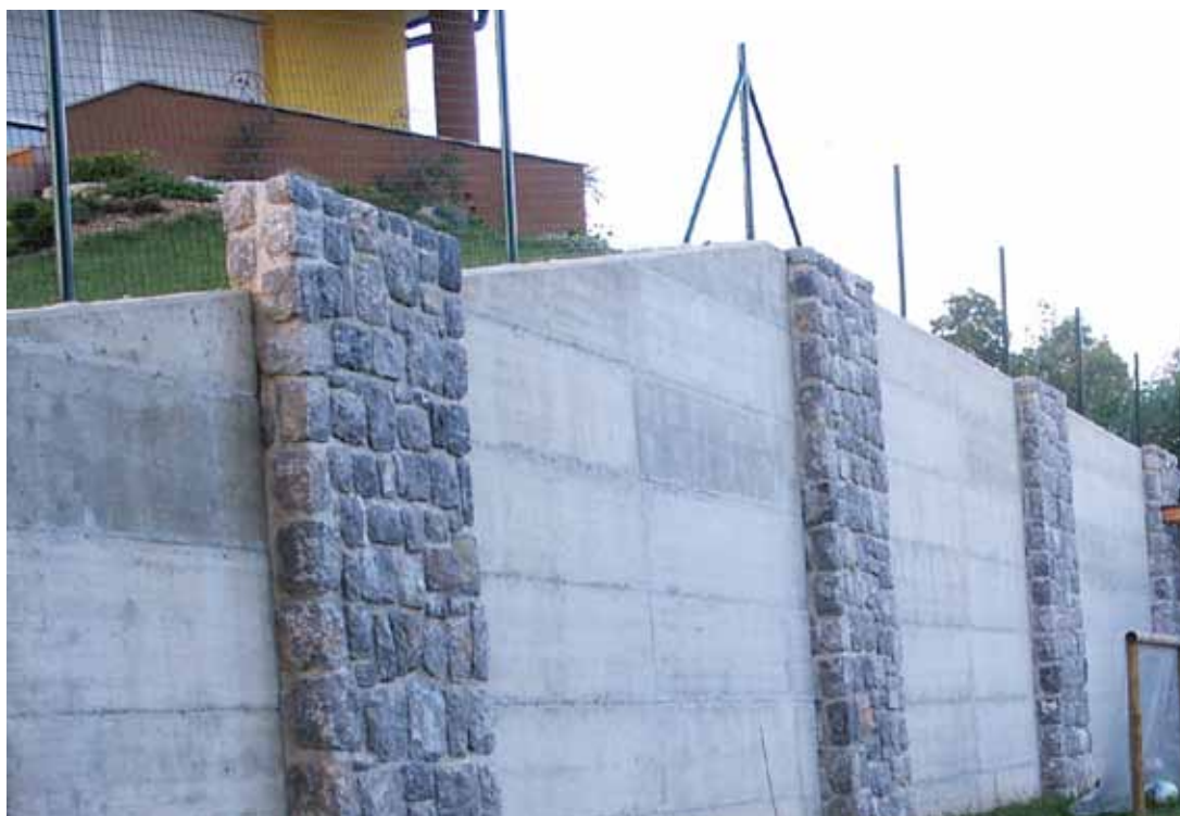
Fotografija 52: Betoniran oporni zid z delno oblogo iz kamna (Vir: Anton Goršič)
