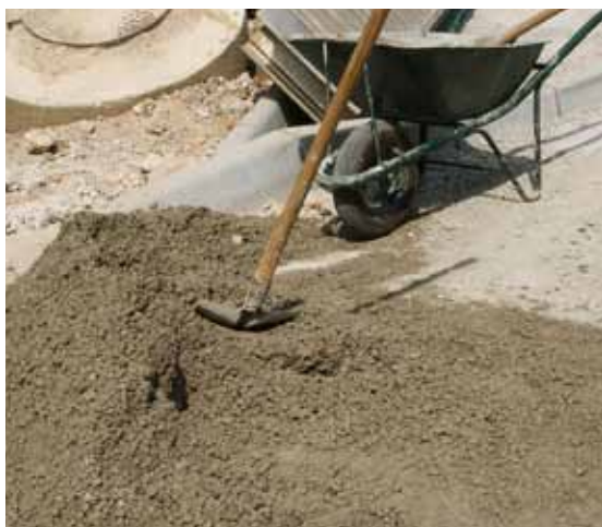
Fotografija 40: Pripravljen beton (Vir: Anton Gorščin)
