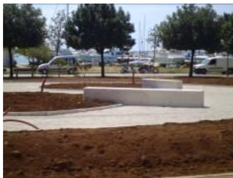
Slika 16: Teren po opravljenih zemeljskih delih in delno gradbenih prvinah (Vir: Pajk B., 2012)
